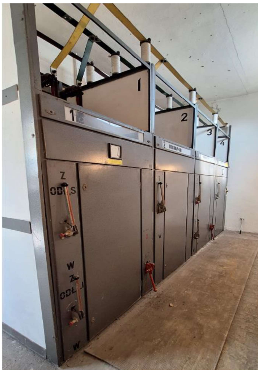
c) Dokumentacja fotograficzna aktualnie zabudowanej rozdzielnicy przedział SN- przód
