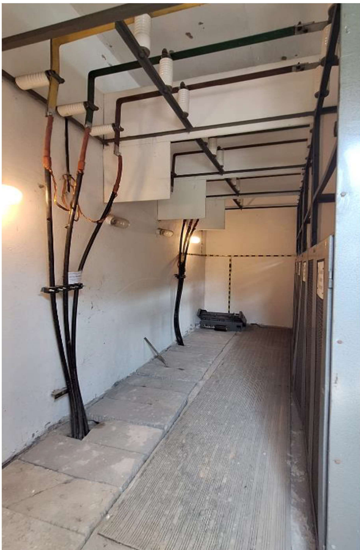
d) Dokumentacja fotograficzna aktualnie zabudowanej rozdzielnicy przedział SN - tył
